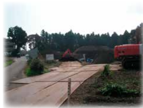
埋め立てられている谷津
