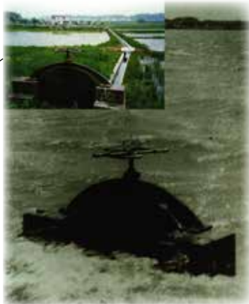
1941(昭和 16)年洪水時の奈良戸水門
