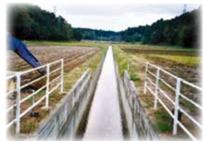
コンクリート化された水路
