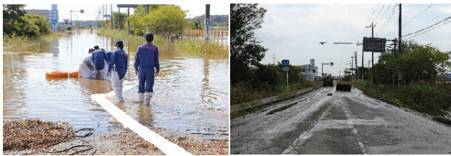
資料①-3 (2019年10月台風後の鹿島川付近) 左：台風後の漏水 右：漏水処理後 (佐倉市写真提供)
