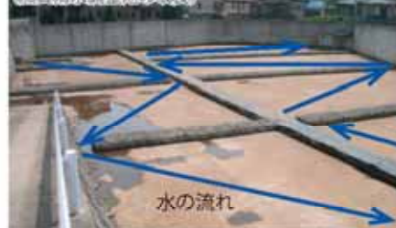
みためし行動市街地・雨水浸透系での現地実験 雨水調整池の改良
