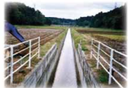
コンクリート化された水路
