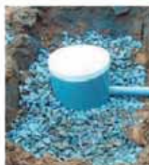
汚濁分離型 雨水浸透マス
