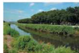
高崎川の河道改修状況
