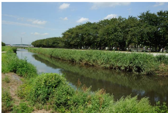
図 44 環境に配慮した河道整備（高崎川）
