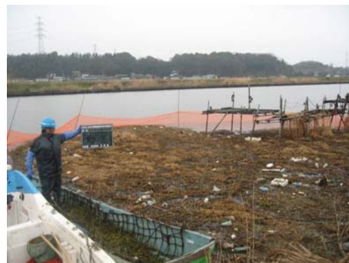
図 81 駆除時の流出対策 (飛散防止ネットで囲む)
