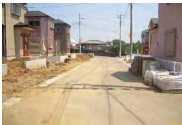
写真 6 宅地内貯留浸透施設を導入した住宅の建設
