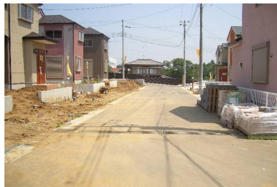
写真 4.8 宅地内貯留浸透施設を導入した住宅の建設
