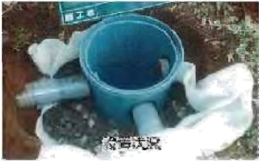
写真 2 浸透マス設置状況
