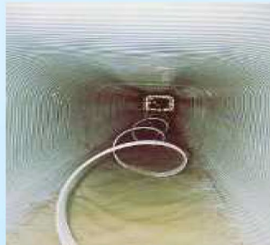
更生工法による長寿命化(下水道)
