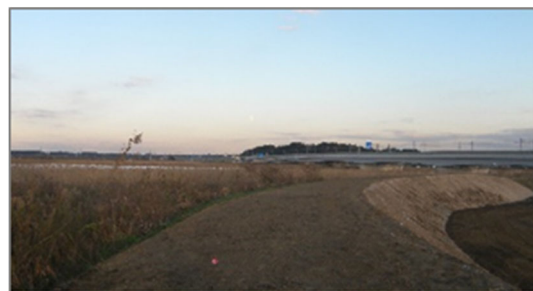
▲築堤完成状況
