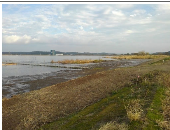
<竣工時の状況>
