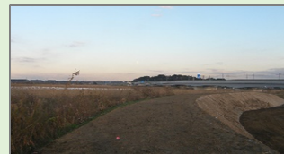
▲印旛沼築堤完成状況
