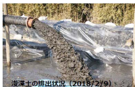
図 1.29 底泥浚渫による水質改善の取組の様子
