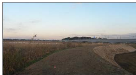
▲築堤完成状況
