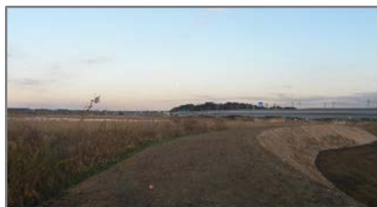
▲築堤完成状況
