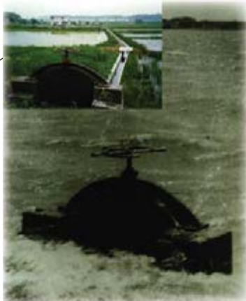
1941(昭和 16)年洪水時の奈良戸水門
