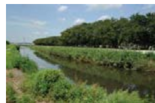
高崎川の河道改修状況
