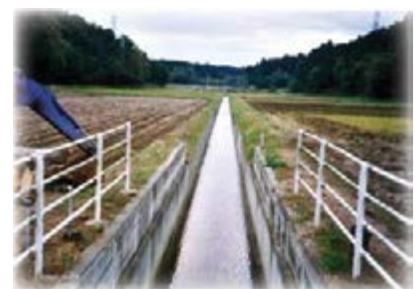
コンクリート化された水路
