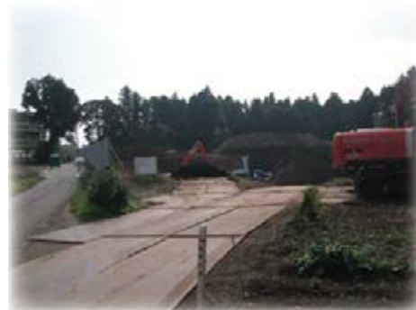
埋め立てられている谷津
