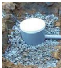
汚濁分離型 雨水浸透マス
