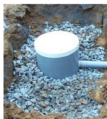
汚濁分離型 雨水浸透マス
