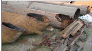
ポンプ羽根車の欠損
