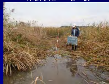
素掘水路工 着工前
