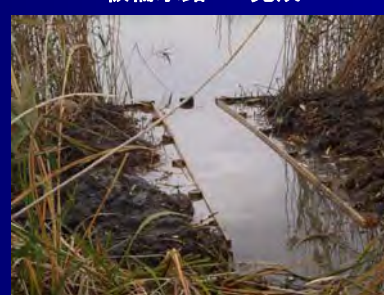
板柵水路工 完成
