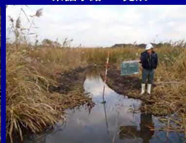
素掘水路工 完成
