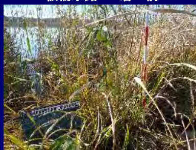
板柵水路工 着工前
