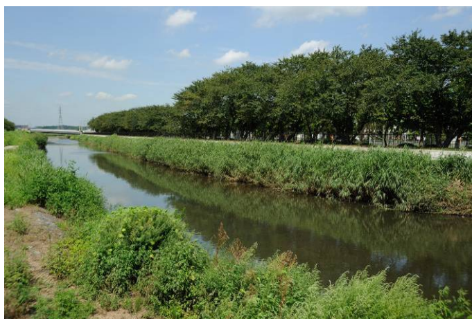
図 3.12 環境に配慮した河道整備(高崎川)
