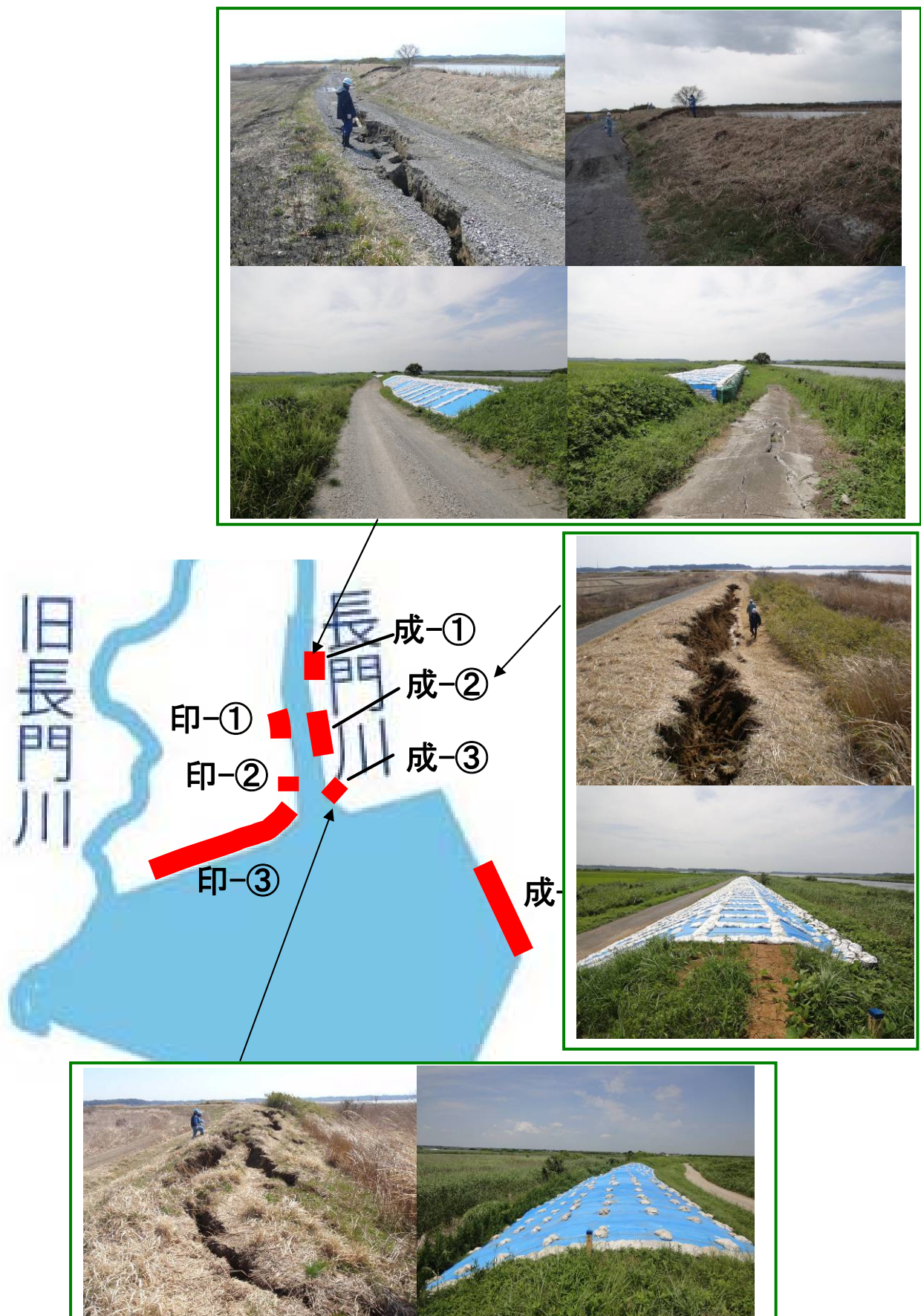
図 7 印旛沼堤防の主な被災箇所及び応急復旧状況 (2)
