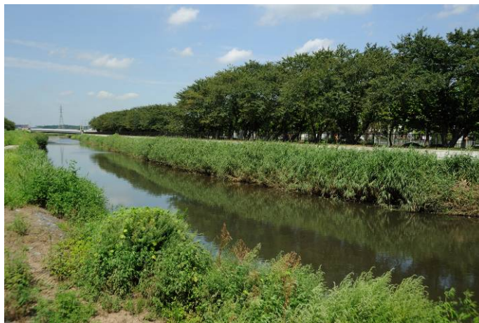
図 3.16 環境に配慮した河道整備（高崎川）
