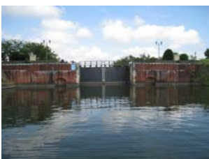
横利根閘門を調査
