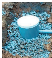
汚濁分離型 雨水浸透マス
