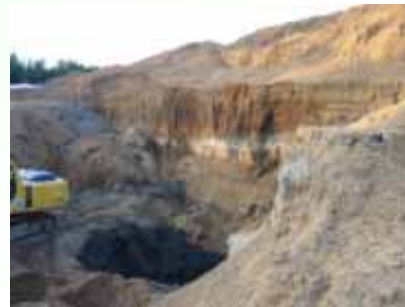
残土埋め立て状況 太田谷津（高崎川流域）
