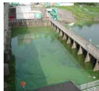
9月3日 大和田機場吸水槽
