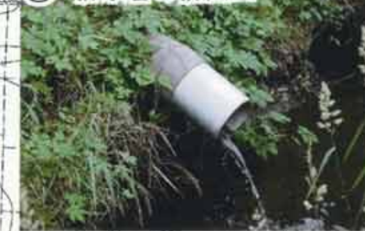
② 排水管の排出口
