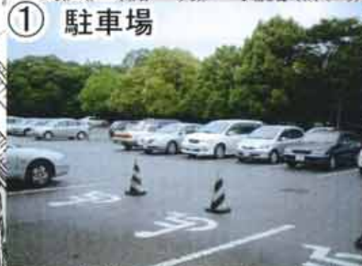
① 駐車場内の側溝
