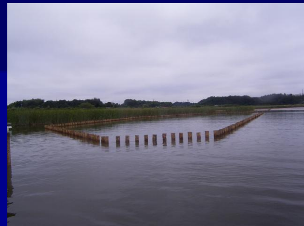
3. 松杭設置完了
