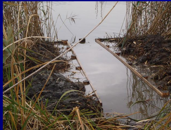
板柵水路工 完成
