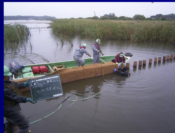
5. 柵板設置②
