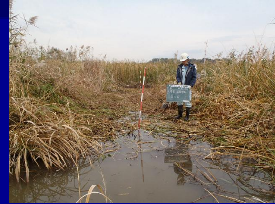
素掘水路工 着工前
