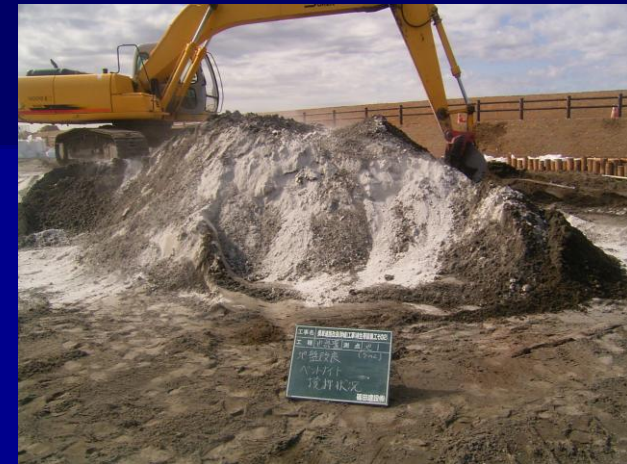
9. 地盤改良工(池底)
