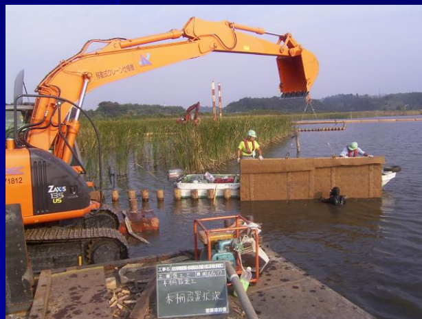
4. 柵板設置①
