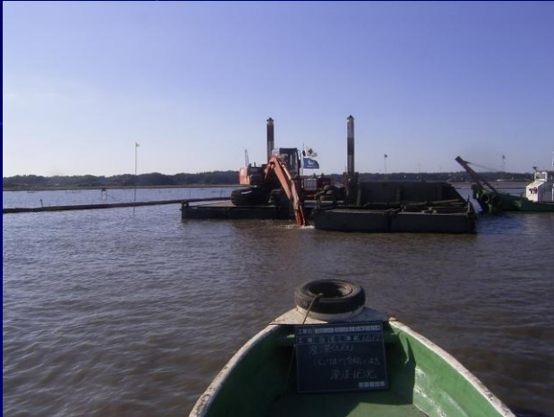
7. バックホウ浚渫
