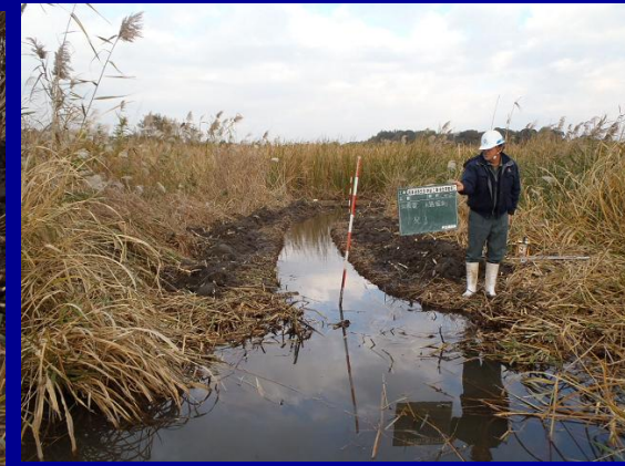
素掘水路工 完成
