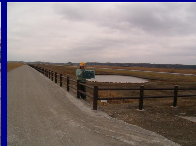
12. 造成工事完成
