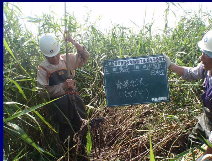
北須賀工区 ヤナギ除去
